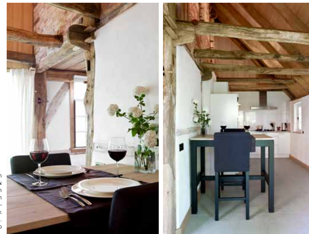
Foto links: de hoge tafel met barstoelen in de keuken zijn gemaakt door Keijser & Co. De keuken is een ontwerp van Keiten Schmitz uit Bocholt. De oude gebinten in De Korenspeker zijn door Aannemingsbedrijf Te Selle uit Winterswijk stuk voor stuk gezandstraald om ze schoon te maken. Ze zijn niet afgewerkt om de uitstraling zo authentiek en puur mogelijk te houden.
